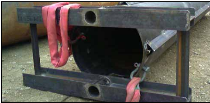
Figura 6: Plantilla para la instalación de columnas
