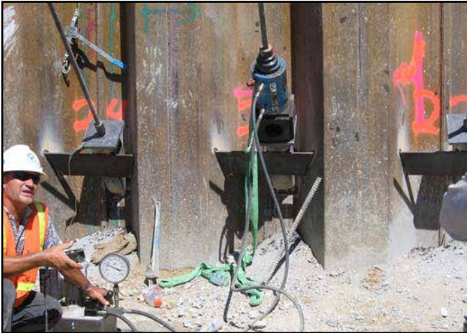
Figura 12: Instalación y tensado de los tirantes en los pilotes de plancha dentro de la zona convencional
