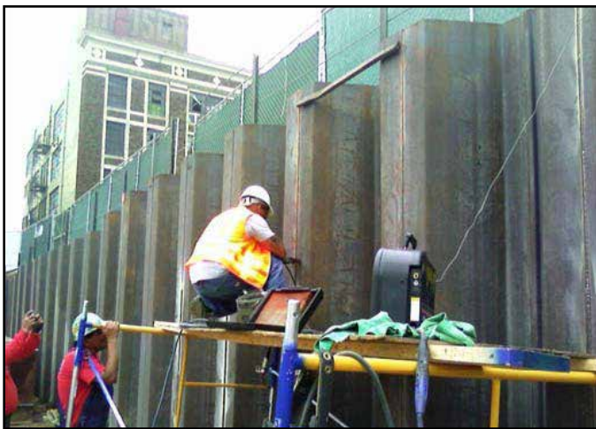
Figura 9: Pruebas con partículas magnéticas después del soldado de los pilotes de plancha
