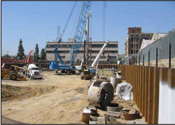
Figura 3: Excavación hasta el nivel P1
