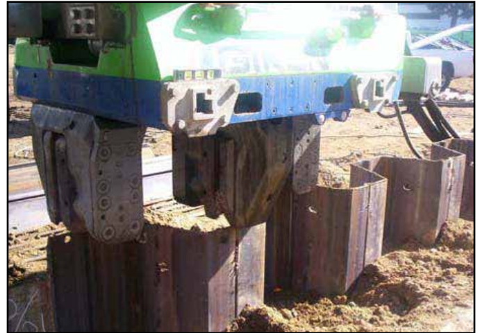
Figura 2: Instalación de pilotes de plancha
